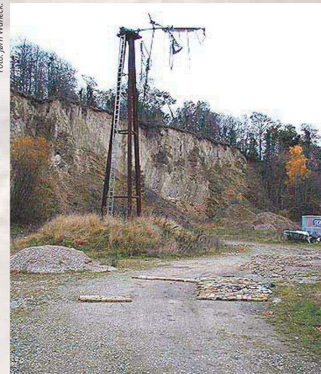
I den sydlige del af den tidligere grusgrav står en stejl væg, hvor man kan iagttage den tidligere bakkes indmad. Lagene står næsten lodrette. Undlad af sikkerhedsmæssige årsager at gå alt for nær ved væggen.
