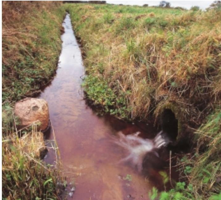
Fig. 2 Vanddråber på planter i en kornmark nær Borsholm. En betragtelig del af fordamningen af nedbøren foregår fra planternes overflade i vækstsæsonen. En del af det vand, som ikke fordamper, siver ned i jorden og kan blive afledt gennem drænrør til drængrøfter, som på billedet.
