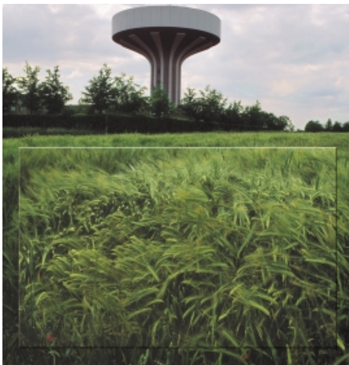
Fig. 4 Kornmark og vandtårn nær Herlev ved København. Vandtårnet placeres så højt som muligt, for at sikre et tilstrækkeligt stort vandtryk i ledningsnettet, så vandet kan nå ud til den fjerneste forbruger. Der bliver jævnligt udtaget prøver til analyse af råvand før vandet når frem til vandværket og ligeledes før det forlader vandværket og pumpes op i vandtårnet og videre til forbrugerne. Det lille billede viser et af GEUS' laboratorier, hvor der bl.a. udføres analyser for indhold af pesticider.
